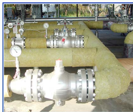
瓦斯管岩棉保溫消音工程
