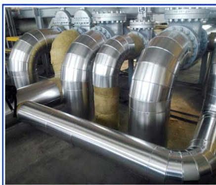
油管岩棉保溫外覆鋁皮板金
