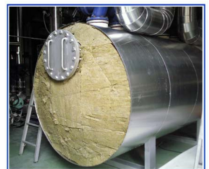
桶槽設備岩棉保溫外覆鋁皮板金
