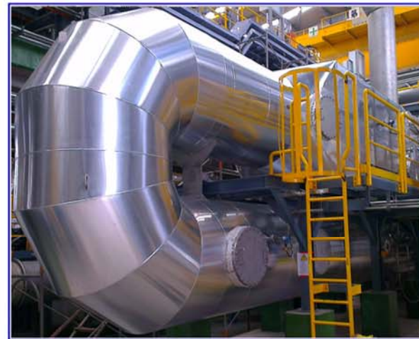
高溫設備陶瓷棉保溫外覆鋁皮板金
