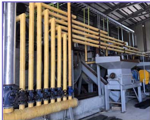
蒸氣管線玻璃棉管保溫包覆
