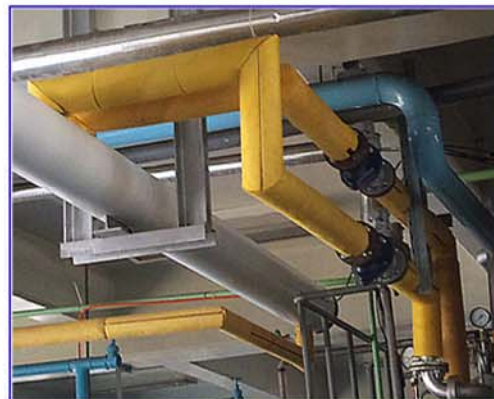
蒸氣管線玻璃棉管保溫包覆
