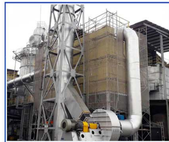
集塵設備岩棉防火保溫施工
