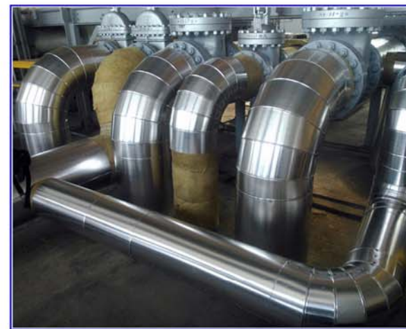
熱媒油管岩棉保溫外覆鋁皮板金
