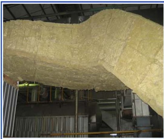
煙道岩棉保溫隔音工程
