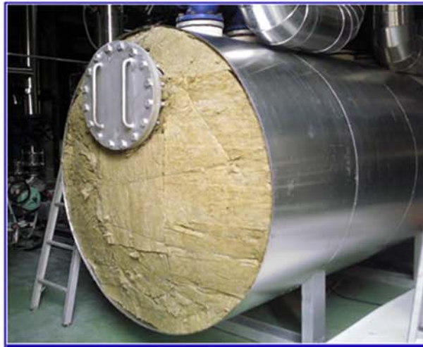
桶槽設備岩棉保溫包覆外覆鋁皮板金
