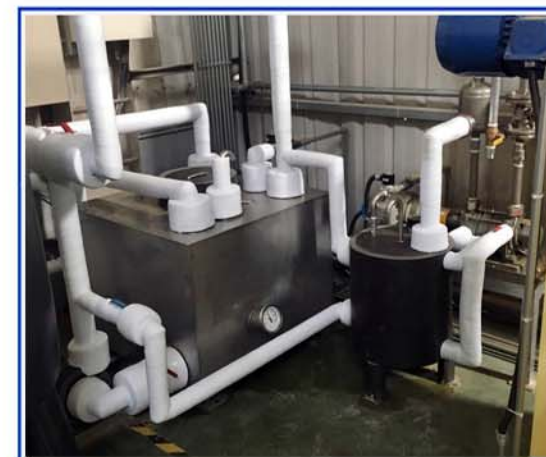
冰水管路保溫外覆PVC防蝕膠帶
