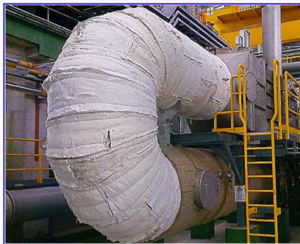
高溫設備陶瓷棉保溫包覆
