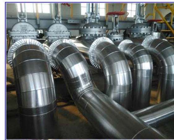
熱媒油管保溫外覆鋁皮板金
