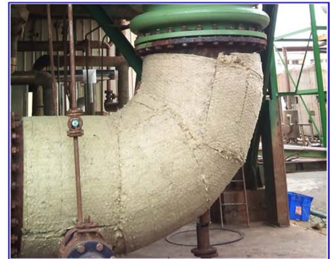
大管徑高溫設備岩棉毯保溫包覆
