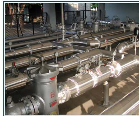
瓦斯管路消音保溫外覆鋁皮板金
