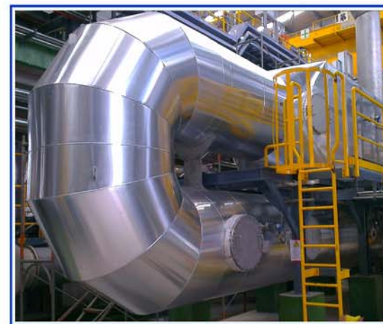
機械設備保溫外覆鋁皮板金
