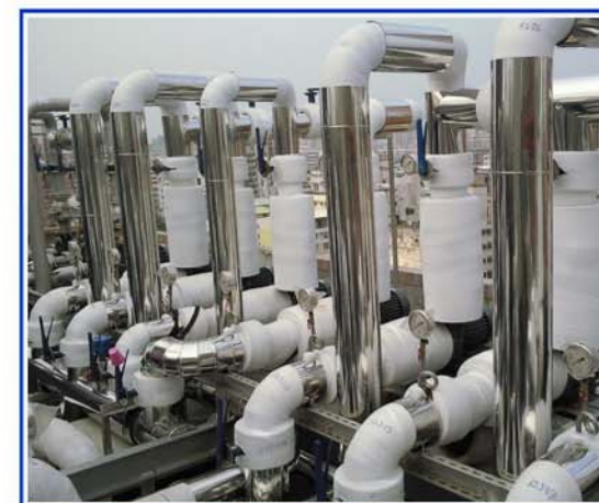
冰水管保溫外加PVC膠帶外覆不鏽鋼板金
