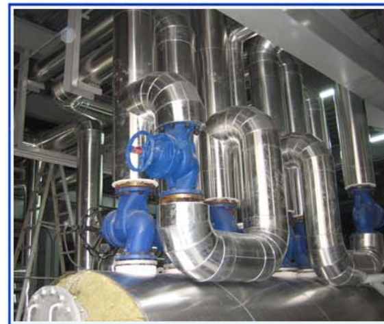
熱媒管保溫外覆鋁皮板金
