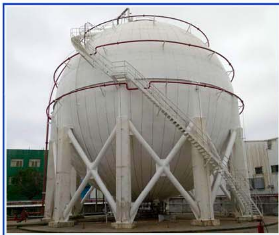
地球型大桶槽保溫外覆烤漆板板金
