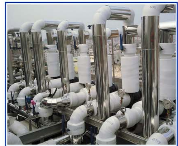
冰水管保溫外加PVC膠帶外覆不鏽鋼板金
