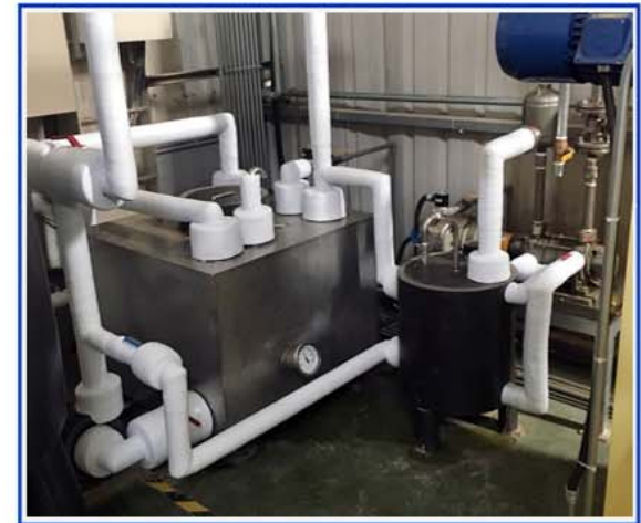
冰水管路保溫外覆PVC防蝕膠帶
