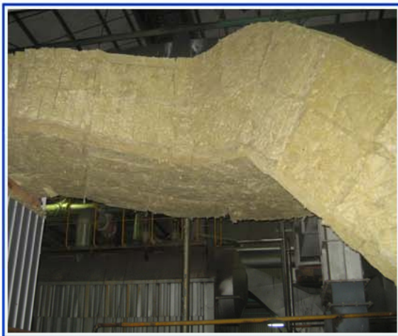
煙道岩棉保溫隔音工程
